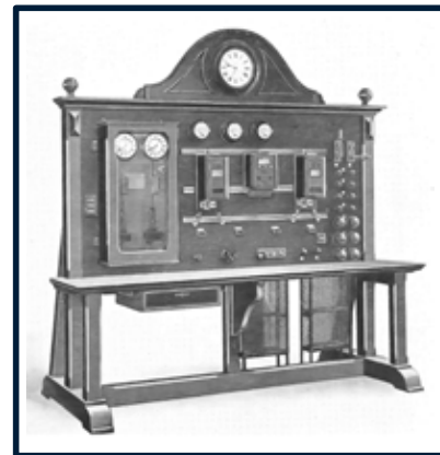
Historische Zählerprüfstation mit Langpendel-Zähler [8]
